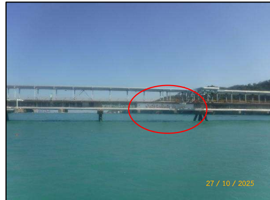
รูปที่ 2-10 ช่องทางสำหรับเรือประมงขนาดเล็กสามารถลอดผ่านได้สะพานท่าเทียบเรือ และป้ายสัญลักษณ์
