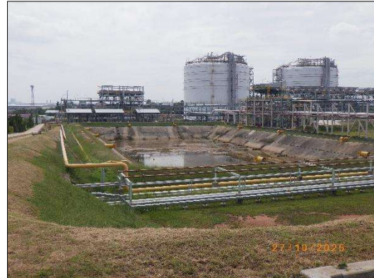
รูปที่ 2-33 บ่อกักเก็บก๊าซ กรณีผลิตภัณฑ์รั่วไหล
