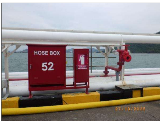
รูปที่ 2-72 ถึงดับเพลิงแบบมือถือบริเวณจุดต่างๆ ของโครงการ
